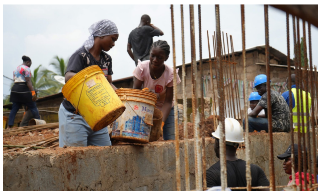
Le chantier début septembre 2026 : fondations et poteaux d'amorce
