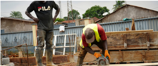
Coffrage des fondations, septembre 2026 • Scellement de la première pierre, 15 août 2026
