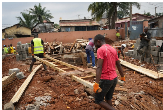
Ferrailage des poteaux d'amorce
