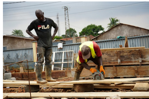
Coffrage des fondations, septembre 2026
