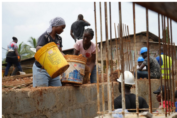
Le chantier début septembre 2026 : fondations et poteaux d'amorce
