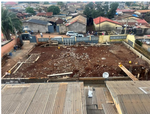
Le site après démolition, juillet 2026
